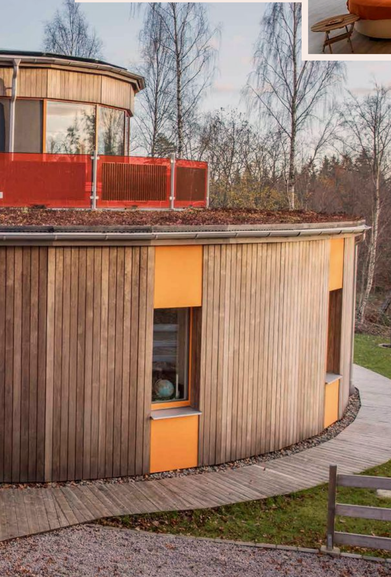
glas. Sedumtaket skyddar och isolerar byggnaden samt bidrar till att förbättra klimatet.
